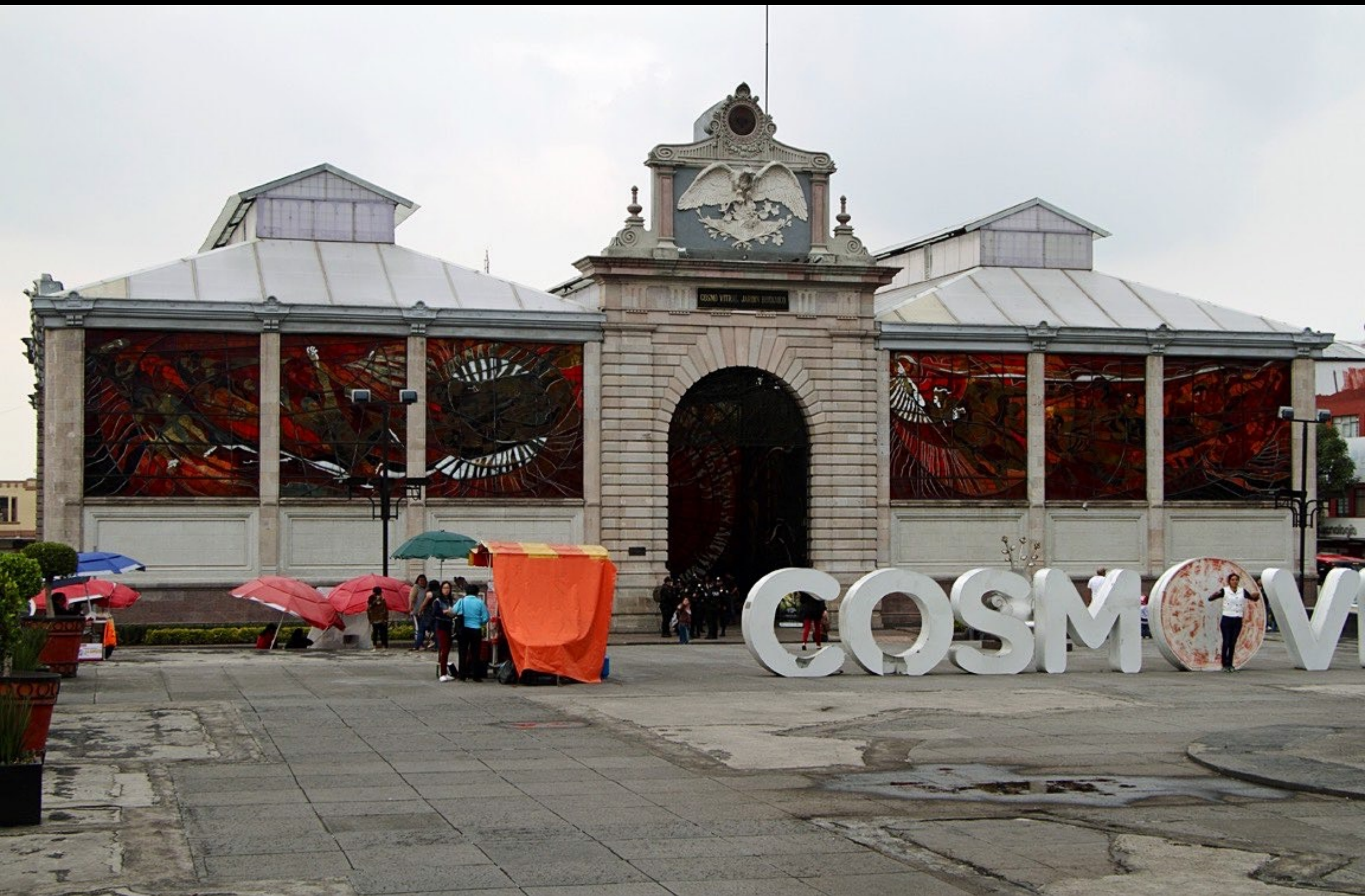
Mercado Cosmovital Toluca (estructura Art Nouveau de hierro forjado, ca. 1910)
